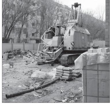
ности. На деле же получилось иначе. Хуже того, накануне прошел дождь, вследствие чего полоса передвижения прилично размякла. Когда кран потерял управляемость и увлек за собой бетонную плиту, его машинист вынужден был в экстренном порядке покинуть кабину.
